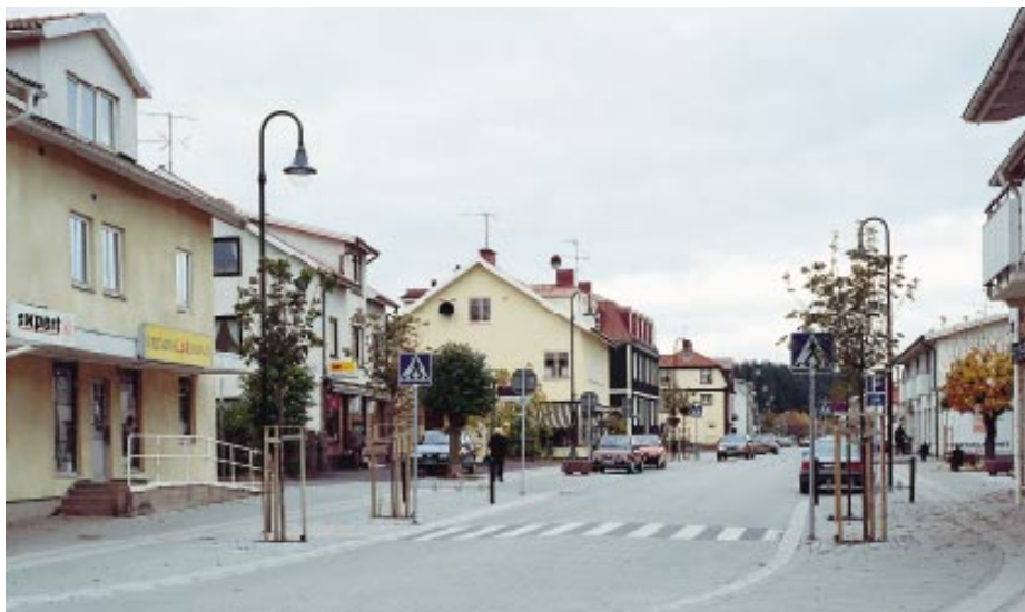
En konsekvent genomförd upprustning av en huvudgata som lugnat ner trafiken. De gående har prioriterats i materialbehandlingen och gatan utgör inte längre den kraftiga barriär den tidigare var (Vårgårda).
