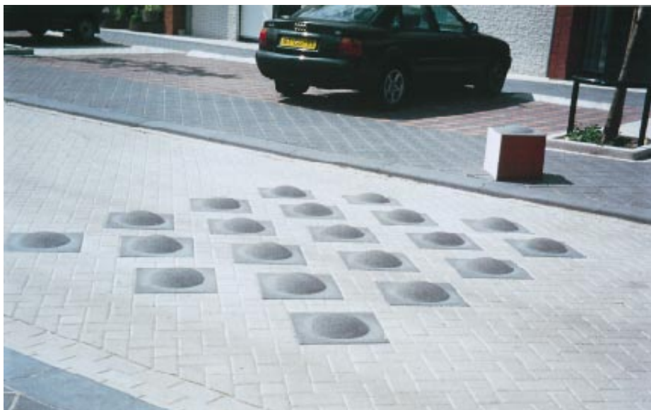
Som alternativ till gupp är dessa »knölar« effektiva då de är mycket obehagliga att färdas över i högre hastighet (Amsterdam, Holland).
