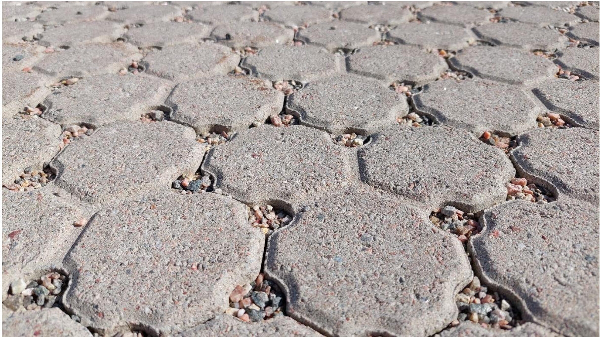
Figur 5-10 Dränerande marksten av typ Delta Drain (Benders) vid Jem & Fix i Vara.
