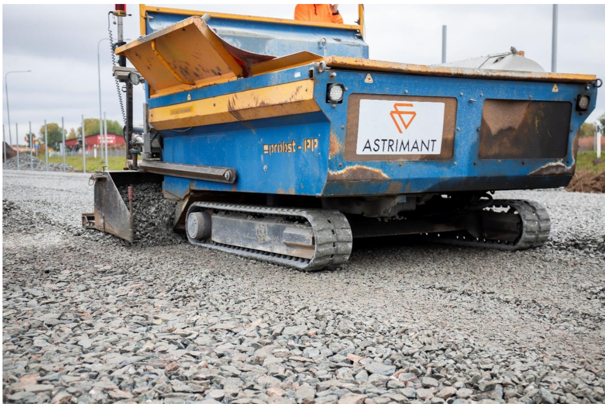
Figur 3-4 Använd helst maskiner med larvfötter. Här utläggning av öppet bärlager över öppet förstärkningslager vid Jem & Fix, Vara
