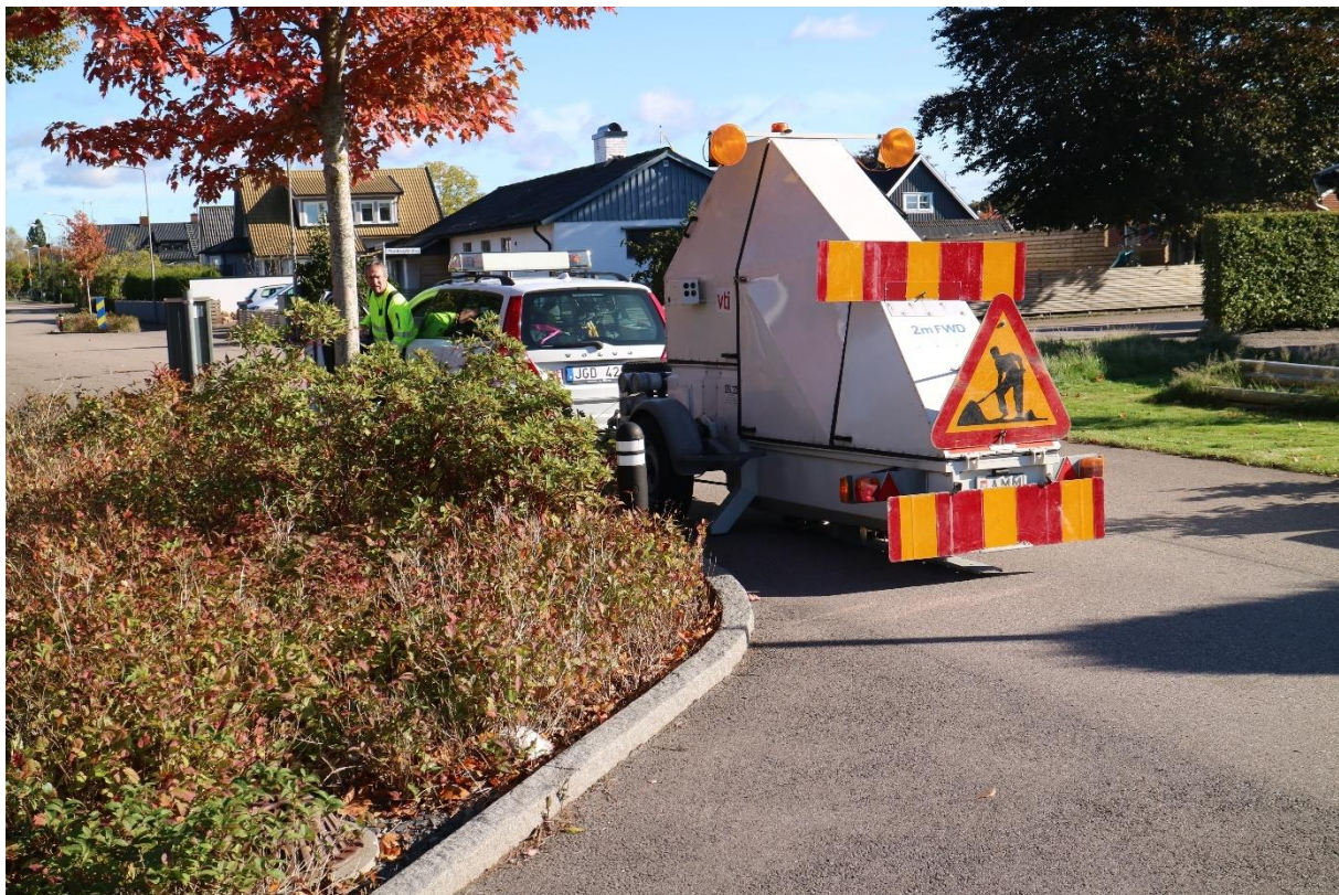
Figur 4-22. Fallviktsmätning på BGG-konstruktion i Munka Ljungby
