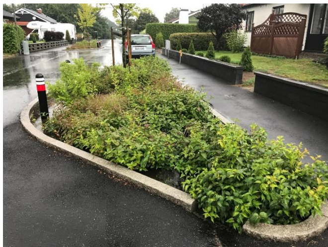
Figur 50 och 51. Redovisar färdigbyggt gaturum med regnbäddar och öppet förstärkningslager under delar av körfält.
