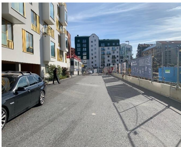
Figurer 13 och 14. Visar på två gaturum i Rosendal med öppet förstärkningslager i hela gaturummets bredd där överbyggnaden är färdig upp till AG. Det vill säga att skede 1 är klart till färdig arbetsgata som kan användas under byggtiden av kvarteren. När kvarten är klara färdigställs gaturummet med att beläggning av marksten med sättlager anläggs samt planteringar.
