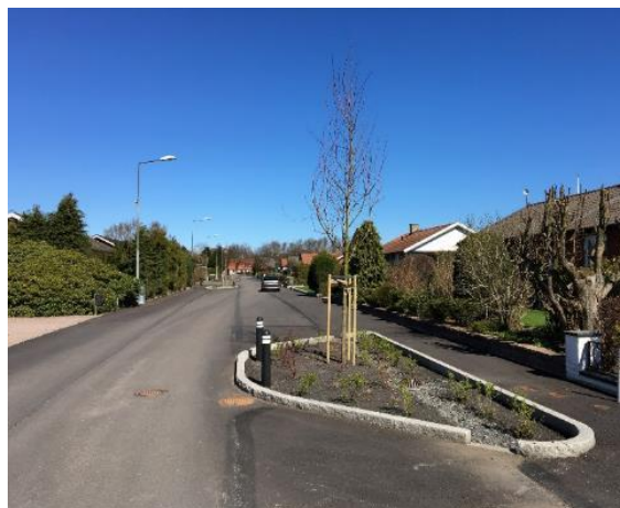
Figur 45. Färdig anlagt gaturum med regnbädd.
