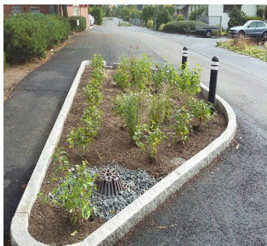
Figur 50 och 51. Redovisar färdigbyggt gaturum med regnbäddar och öppet förstärkningslager under delar av körfält.
