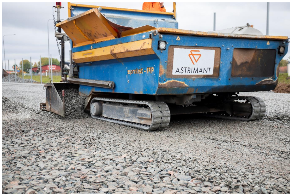
Figur 53. Utläggning av bärlager på öppet förstärkningslager, Jem & Fix, Vara. Larvburen läggare minskar risken för spårbildning.
