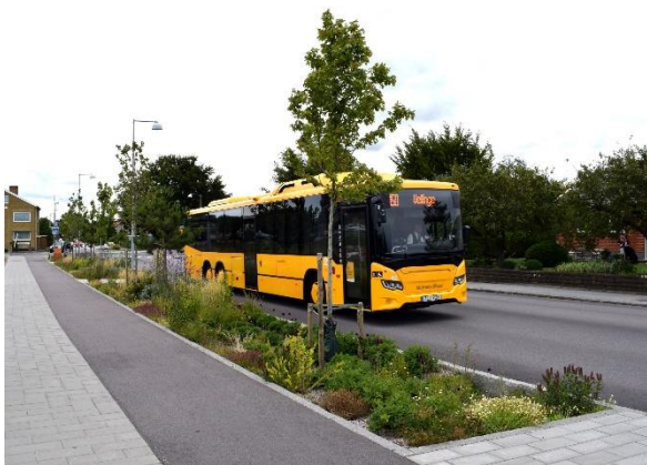
Figur 28. Område 7. öppen överbyggnad med tät beläggning och planteringar (regnbädd).
