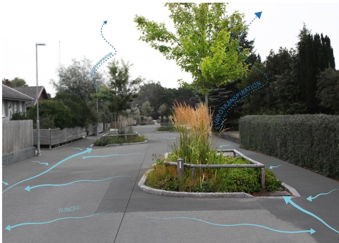
Figur 31. Redovisar avrinningsflöden till regnbäddarna på Rundelsgatan i Vellinge.
