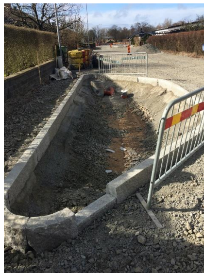
Figur 49. Regnbädd innan placering av växtsubstrat.
