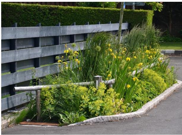
Figur 39 och 40. Regnbäddar med öppet förstärkningslager på Rundelsgatan.
