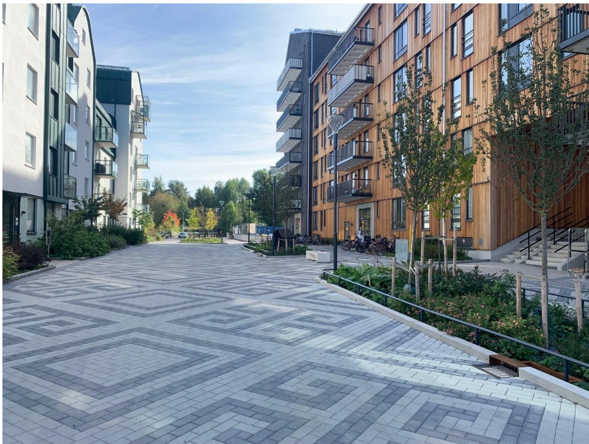
Figur 10. Amanuensgatan i Rosendal med öppet förstärkningslager i hela gaturummets bredd och med regnbäddar dit avrinningen leds (Edge).
