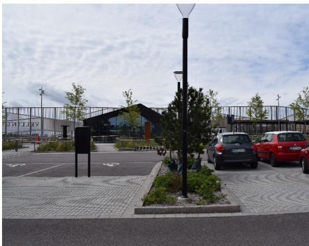
Figur 22. Område 1. öppen överbyggnad med dränerande och tät beläggning.
