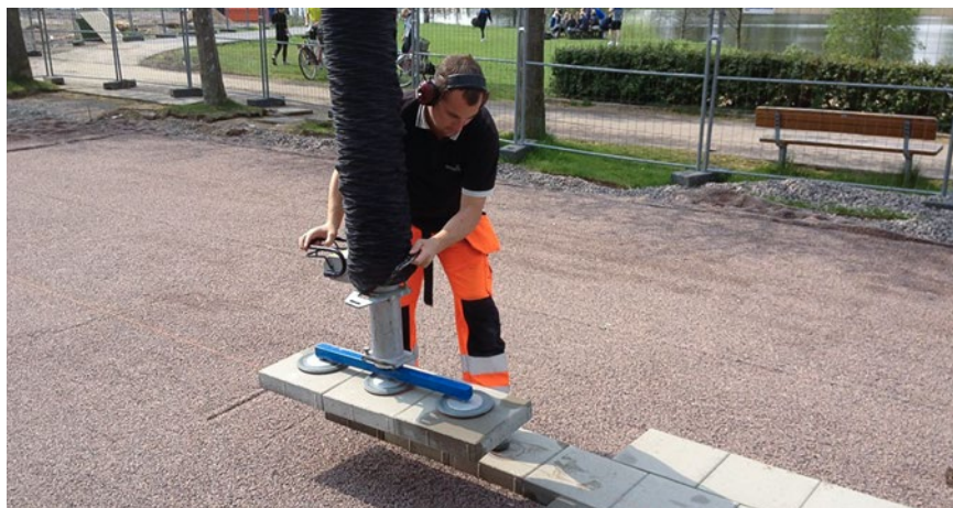
Läggmaskin med vakuumsug.
