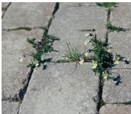
Ofyllda fogar skapar förutsättningar för ogräs.
