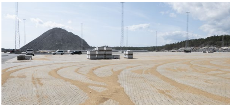
Efter avslutad vibrering fogas beläggningen riktigt.
