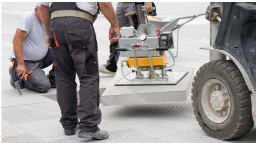
Specialverktyg för att lyfta enskilda markstenar ur en beläggning.
