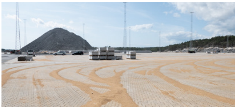
Efter avslutad vibrering fogas beläggningen rikligt.
