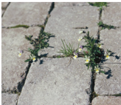
Ofyllda fogar skapar förutsättningar för ogräs.
