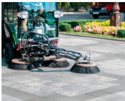
Djupborstande sopmaskiner kan skada fogarna, särskilt på nya beläggningar.
