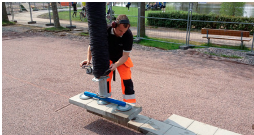
Läggmaskin med vakuumsug.
