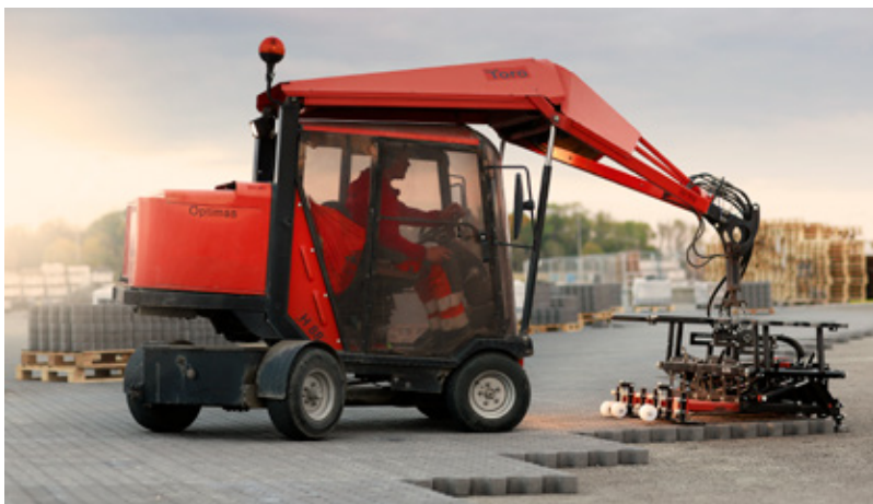
Maskinen arbetar med modulmått och lyfter och lägger en modul i taget. Fogning sker direkt efter läggning.
