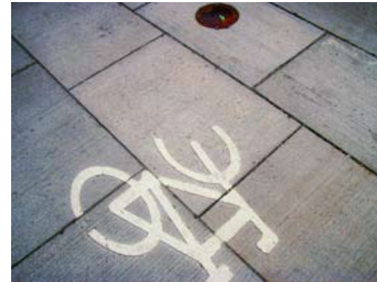
Brett rektangulär platta med borstad yta i olika riktningar, lagd i rader i tredjedels förband. Fredriksbergs centrum, Köpenhamn.
