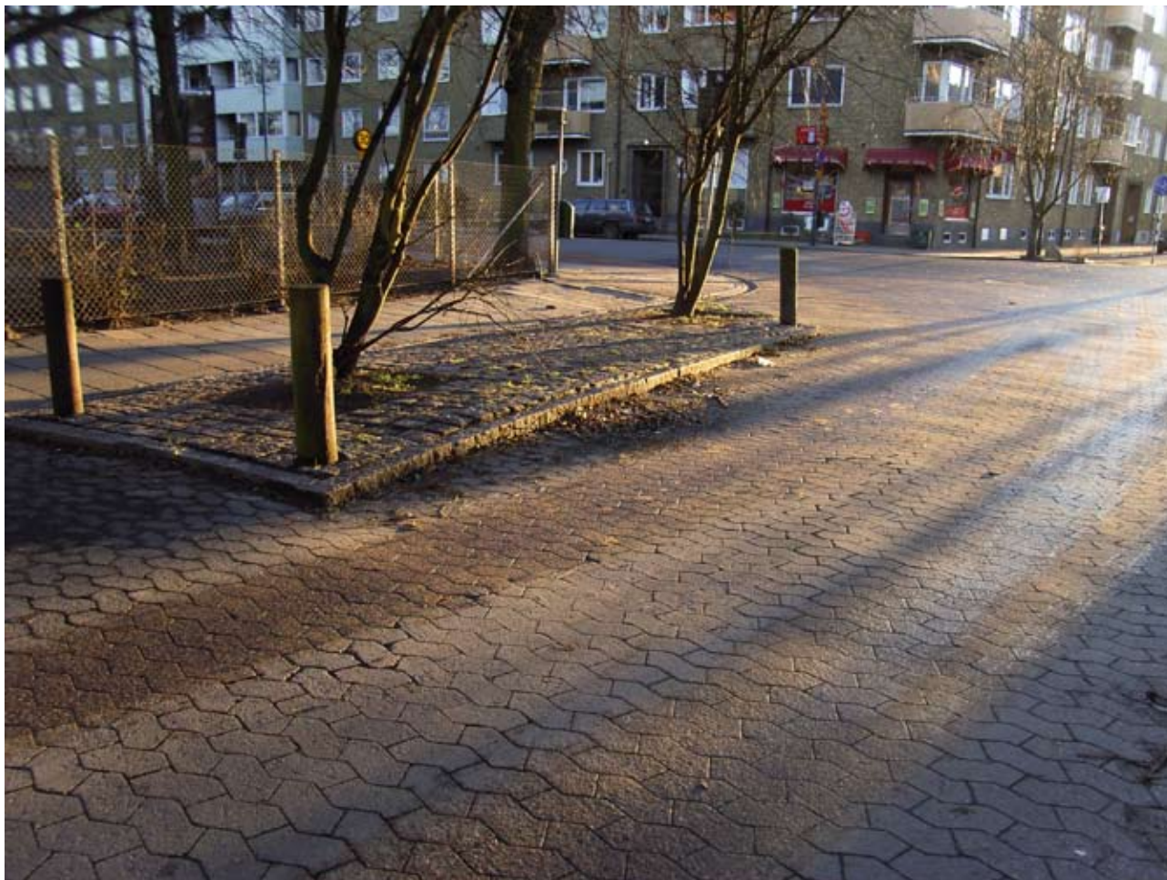
Beläggning av låssten på gata. Västra Sorgenfri, Malmö.
