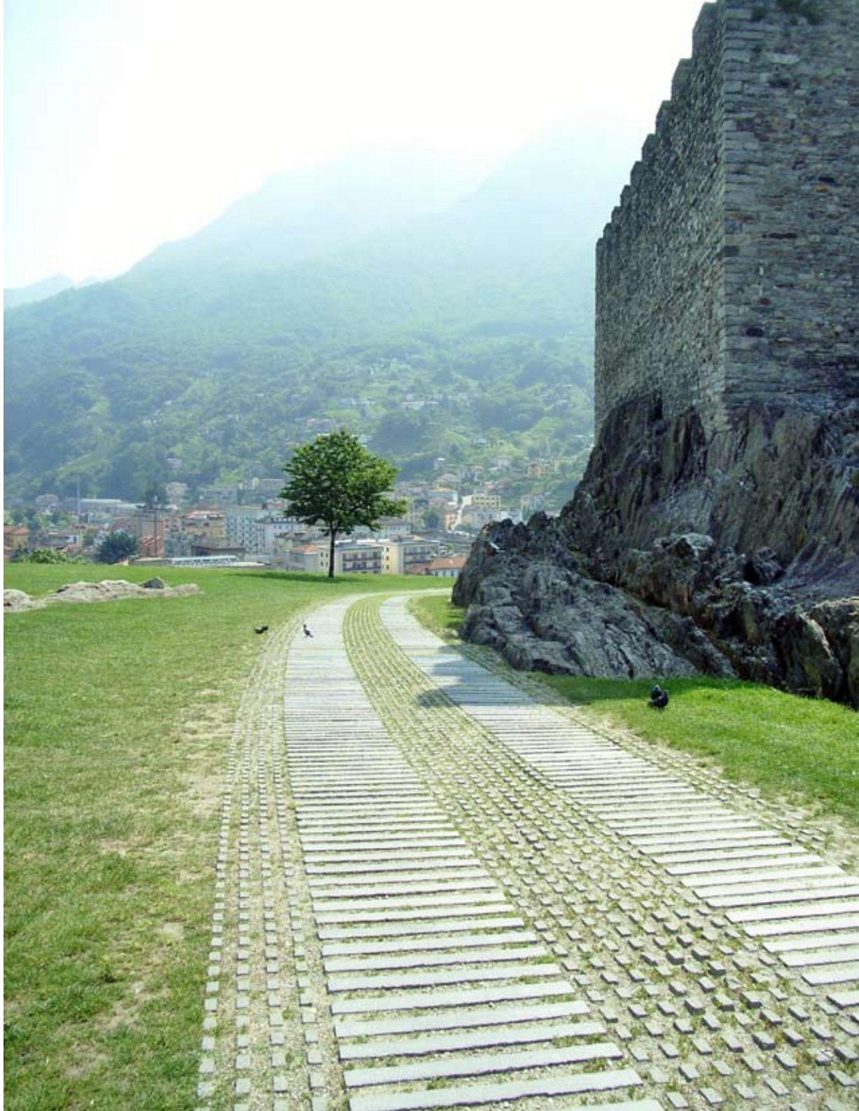
Gräsarmerings- sten som bildar mellanrum på Cita- dellet i Bellinzona, Schweiz.
