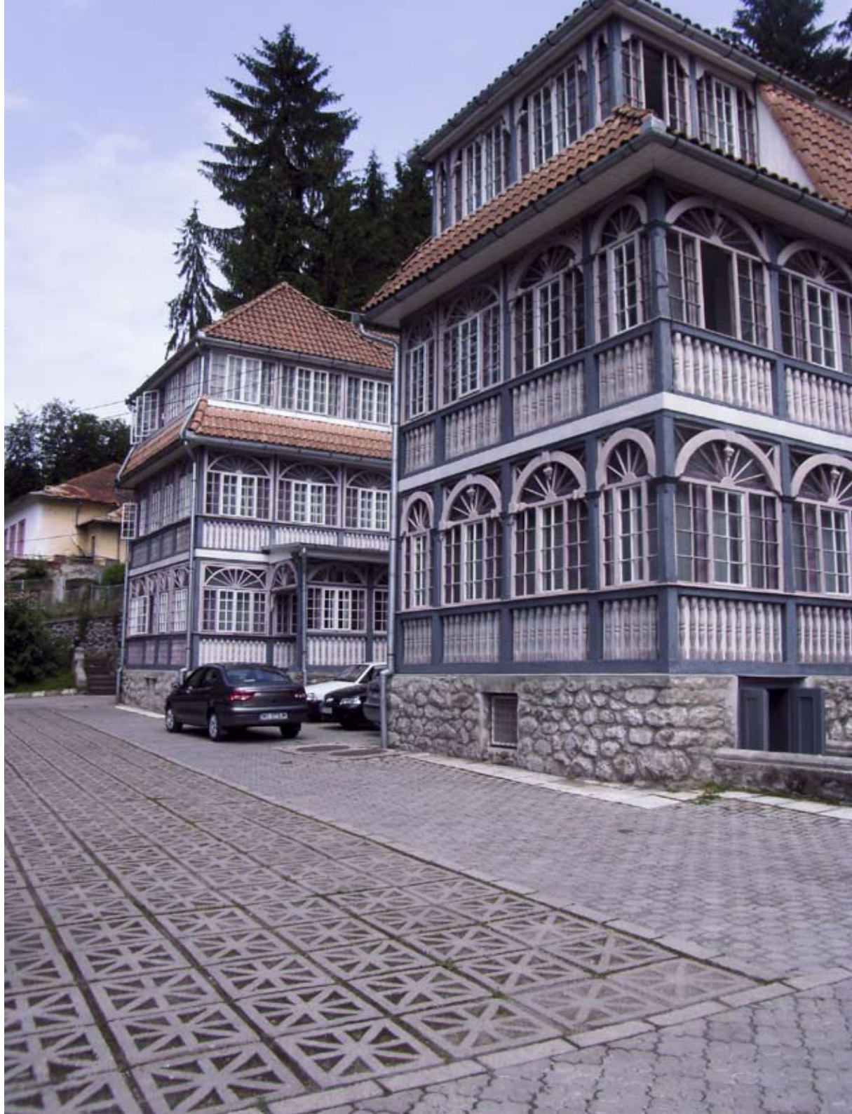
Gräsarmeringssten med hål för gräset att växa i, Sovata, Rumänien.
